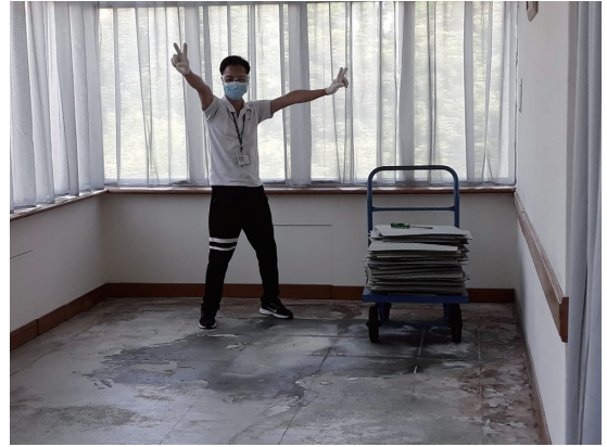
圖十二 館務組同仁協助地毯拆除。照片由採編組張淑慧提供
