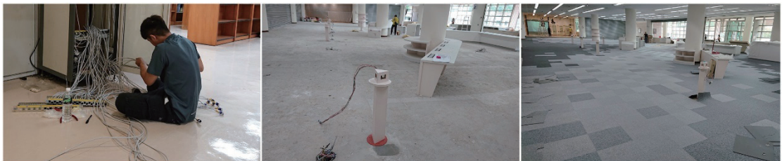
圖八 工程接近尾聲，櫃體大致完成，水弱電師傅再次整理千絲萬縷的線路以供讀者有順暢的網路使用，並開始拼貼地毯與等待家具進駐
