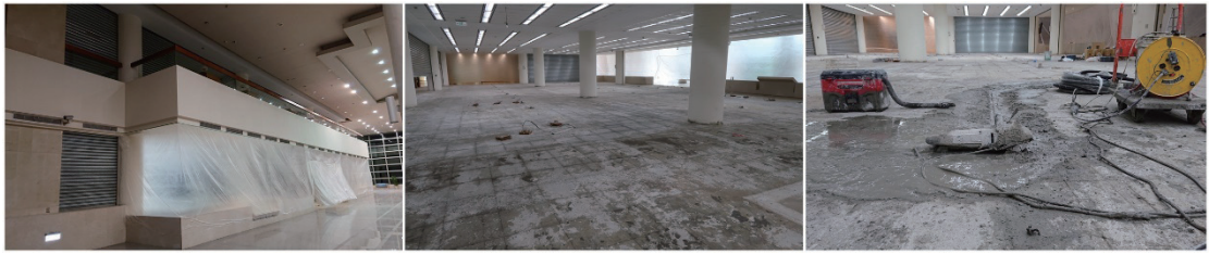
圖五 拆除工程後的圖書館一樓，施工範圍以防火鐵捲門及養生膠帶隔離粉塵逸散，開始進行線路切割等基礎工程
