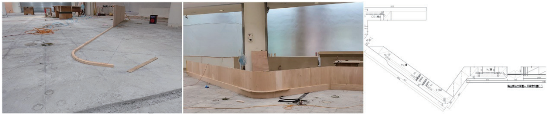
圖六 由木條到立體的流線型櫃體，來自木工職人多年累積的經驗與手藝，完美將設計平面圖具體化
