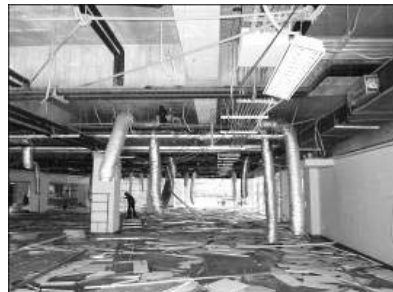
圖七 鋪線工程
