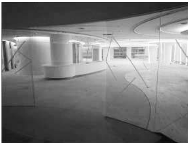
圖六 鋪線工程
